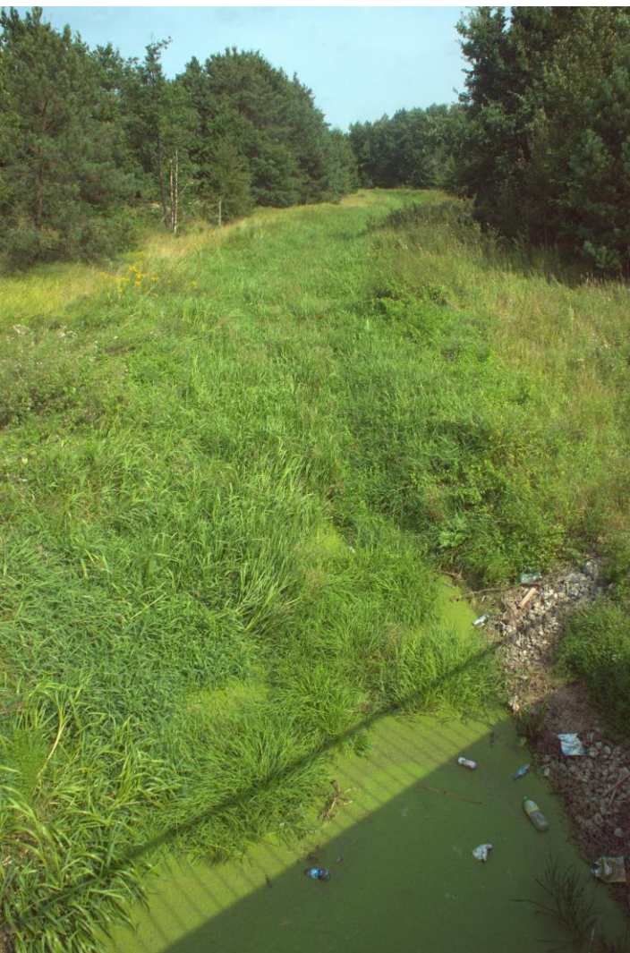
Kanał przerzutowy Czarnej w Czachówku - lipiec 2017 r. (fot. J. Suchożebrski)
